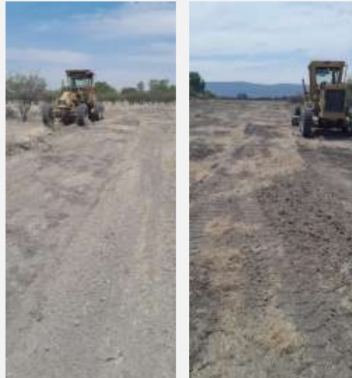
TERRENO PARA ESTACIONAMIENTO
