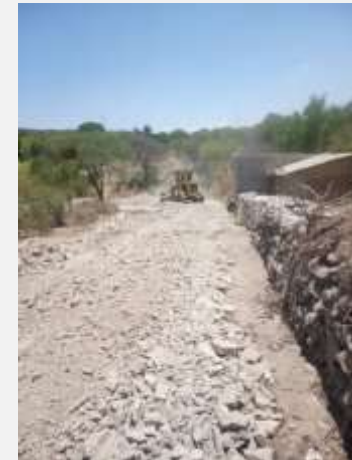
CALLE ACCESO AL TEMPLO
