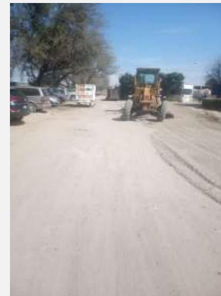
ACCESO A RASTRO MUNICIPAL
