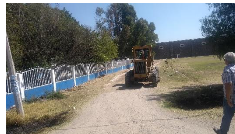
CALLE DE ESCUELA PRIMARIA
